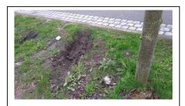
Sickermulde in Tornesch: Tiefe der Beschädigung mehr 20 cm
